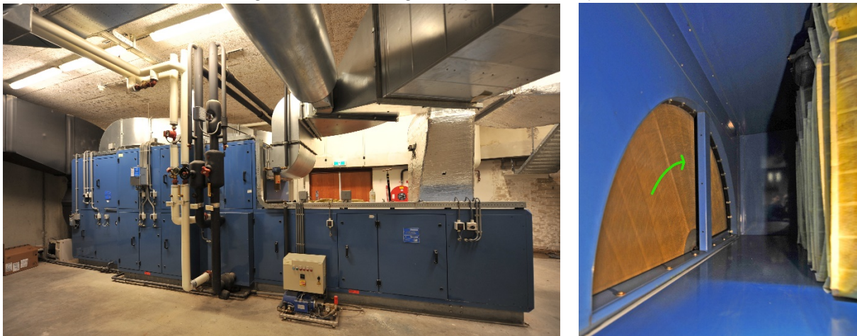
Grote luchtbehandelingskast met warmtewiel WTW als energiebesparingsmethode. Het warmtewiel – rechts in beeld – draait langzaam van de warme 'vuile' retourkant naar de daarboven gelegen koude aanvoerkant. Alleen bij afdoende filtering van de aangevoerde lucht achter het warmtewiel kan zo'n systeem 'Corona-veilig' functioneren. Uiterst rechts in de rechter foto zijn de standaard luchtfilters van het systeem te zien; deze zijn ontoereikend effectief voor het afvangen van virusdeeltjes! © ejn
